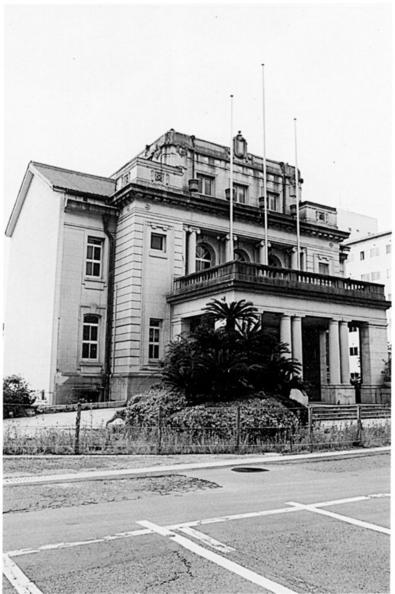
曳家工事前の旧鹿児島県庁舎本館
