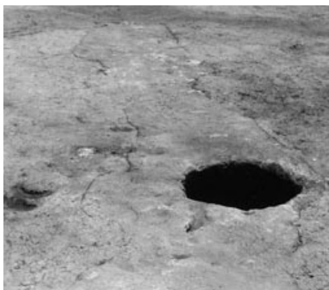
古道硬化面検出状況
