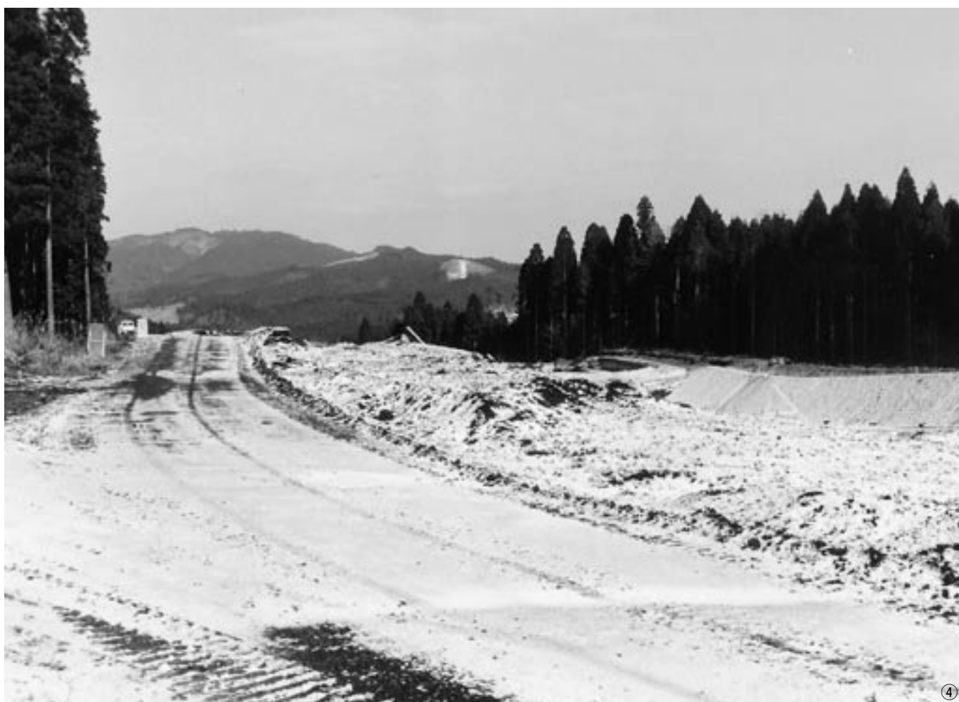
①E-12区古道跡断面 ②C-12区古道跡断面 ③X V層発掘調査風景 ④九養岡遺跡近景
