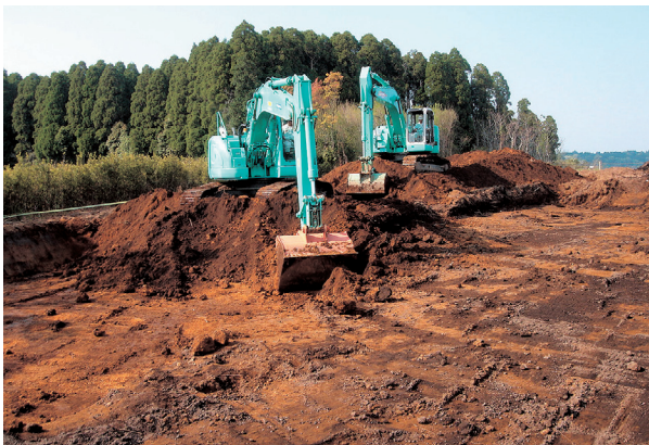
重機による表土剥ぎ
