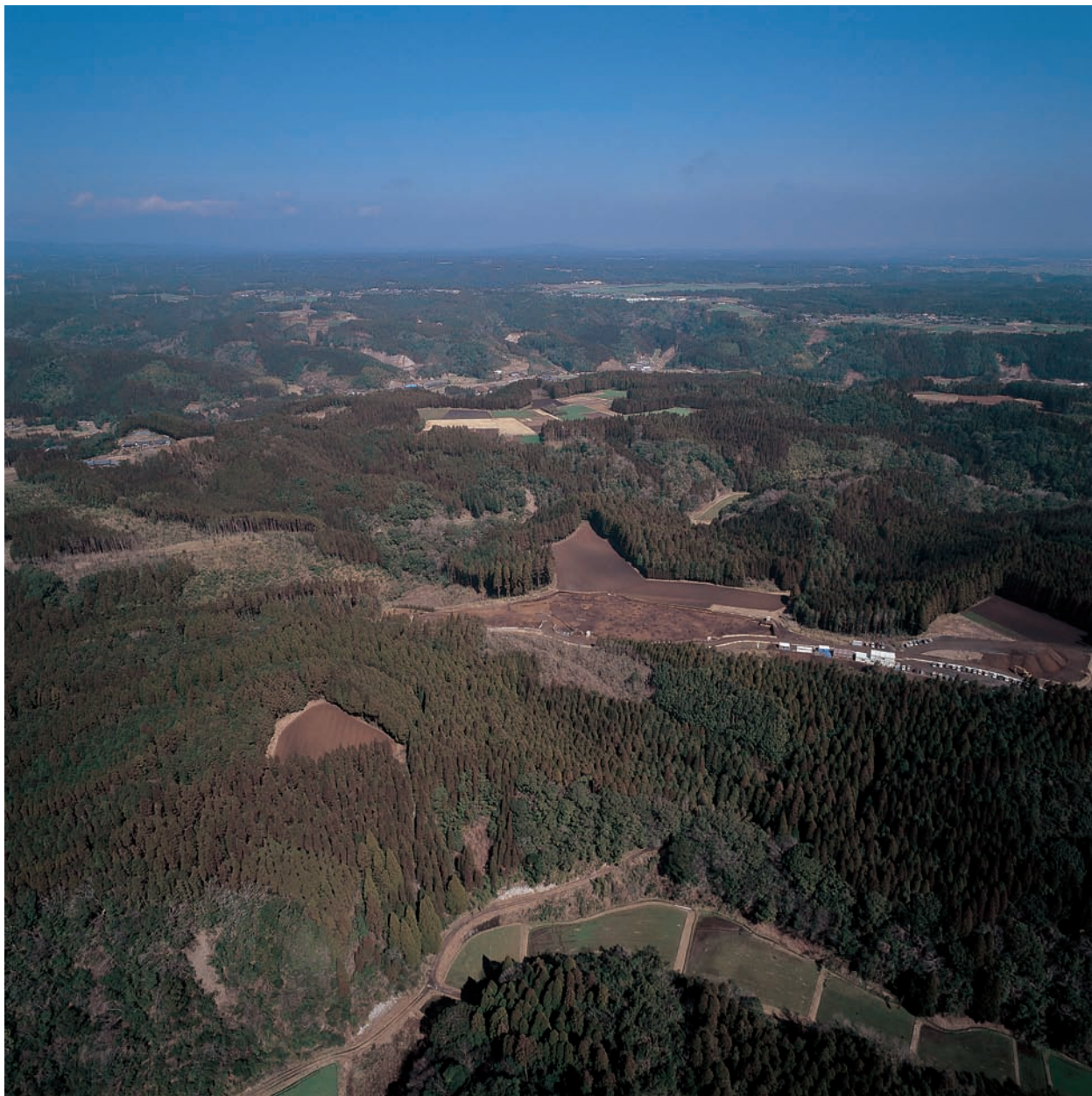
遺跡遠景（南東上空から）
