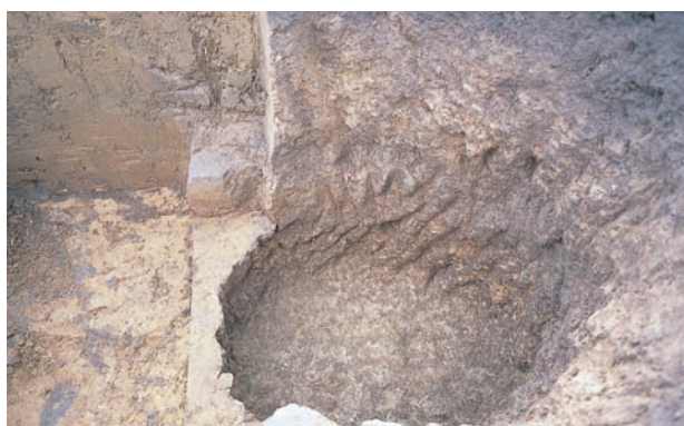
壁面に残る掘削痕
