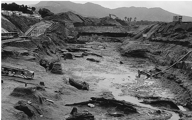
F-24~27区 流木検出状況
