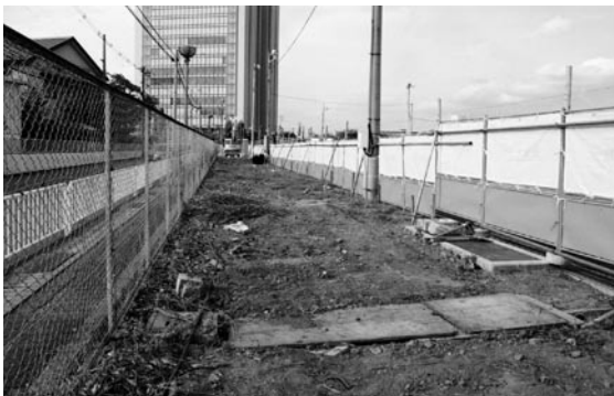
第4図 調査前の状況（南から）
