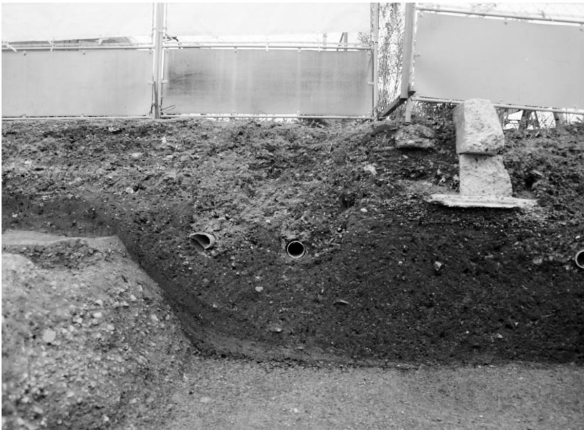
(2) 本丸の堀断面 (西から)
