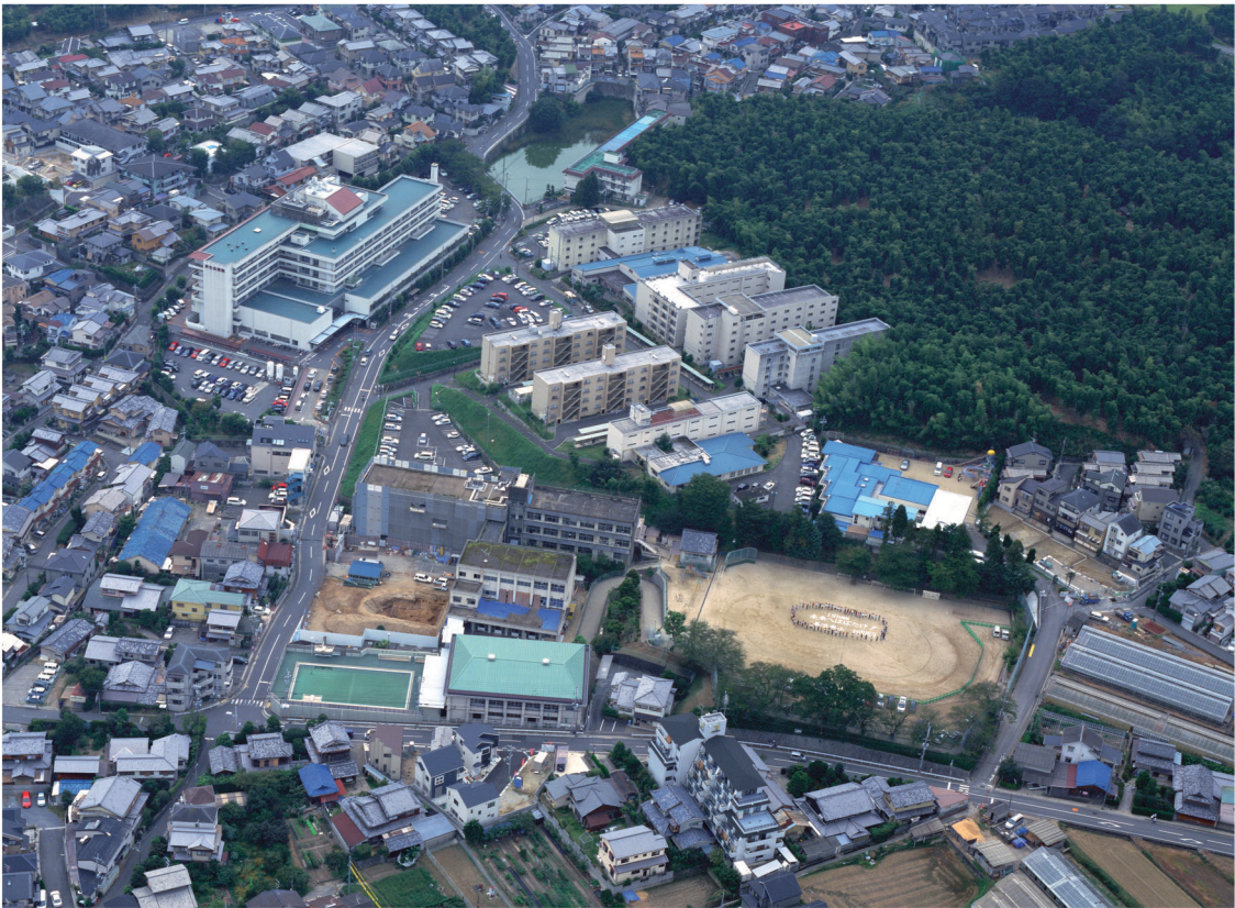
(1) 調査地遠景(北から)
