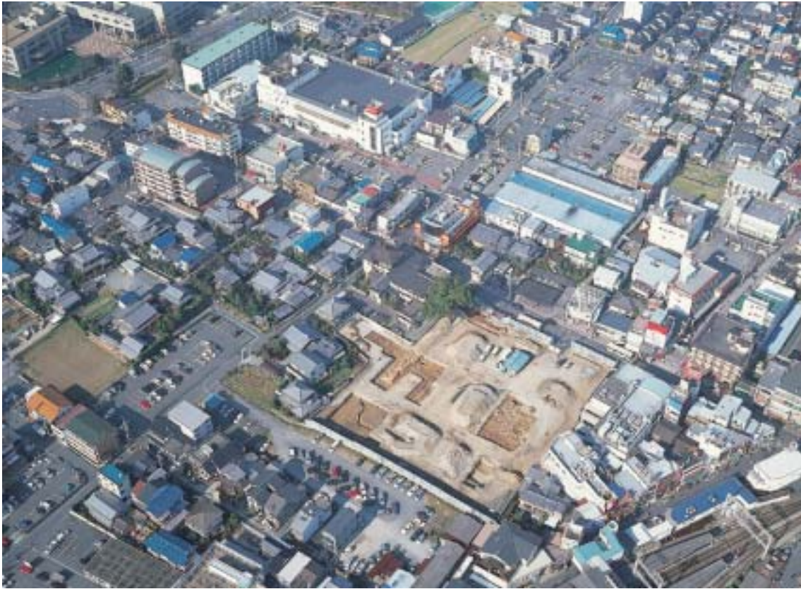
(1) 調査地全景(南東から)
