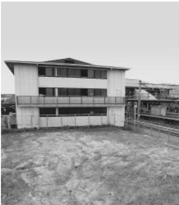
第3図 調査前の状況（北から）
