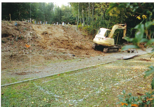
第6図 8-4調査区調査前風景（東から）
