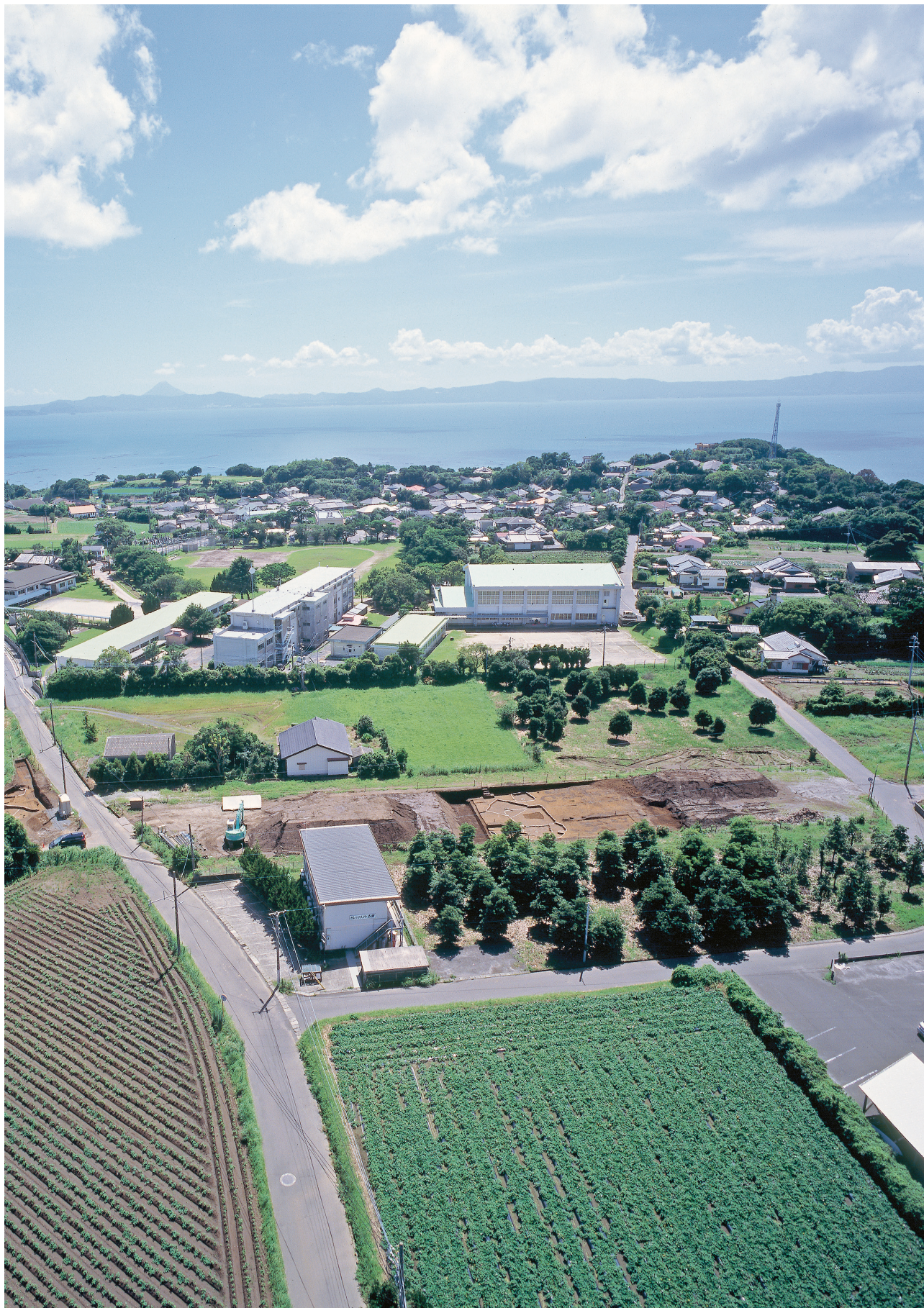
遠景2（北東から南西方向を望む）
