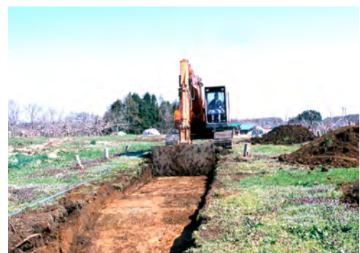
重機トレンチ作業
