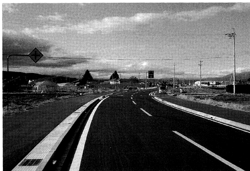
工事終了後の風景 平成16年12月
