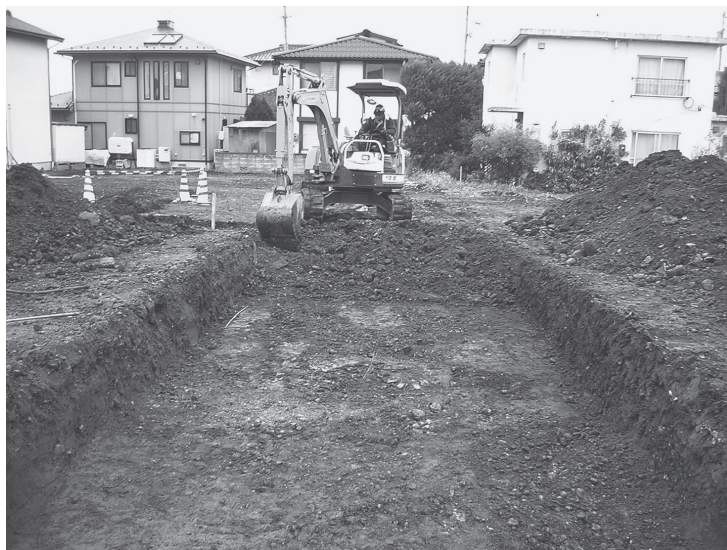
重機掘削状況
