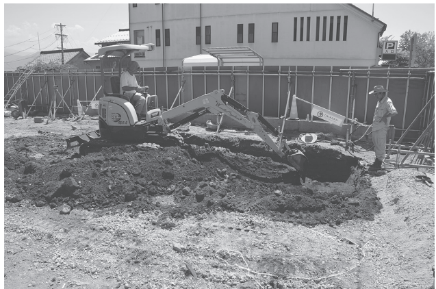
重機掘削作業
