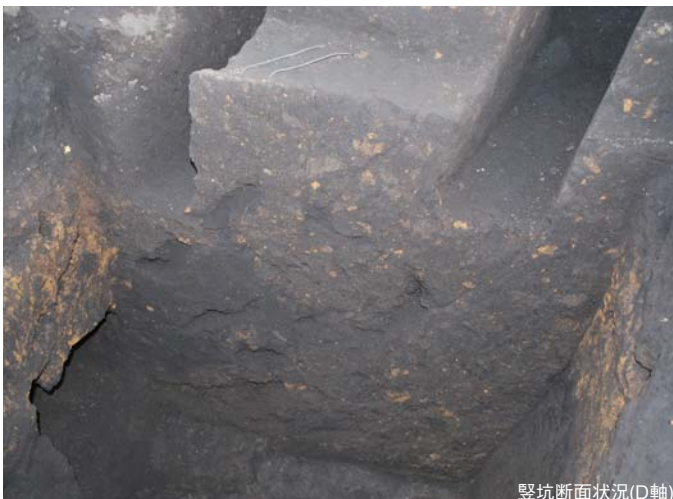
豎坑断面状況(D軸)
