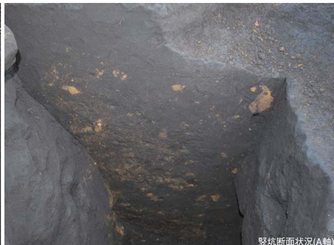
豎坑断面状況(A軸)
