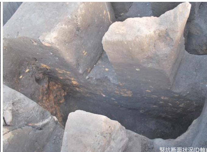
豎坑断面状況(D軸)
