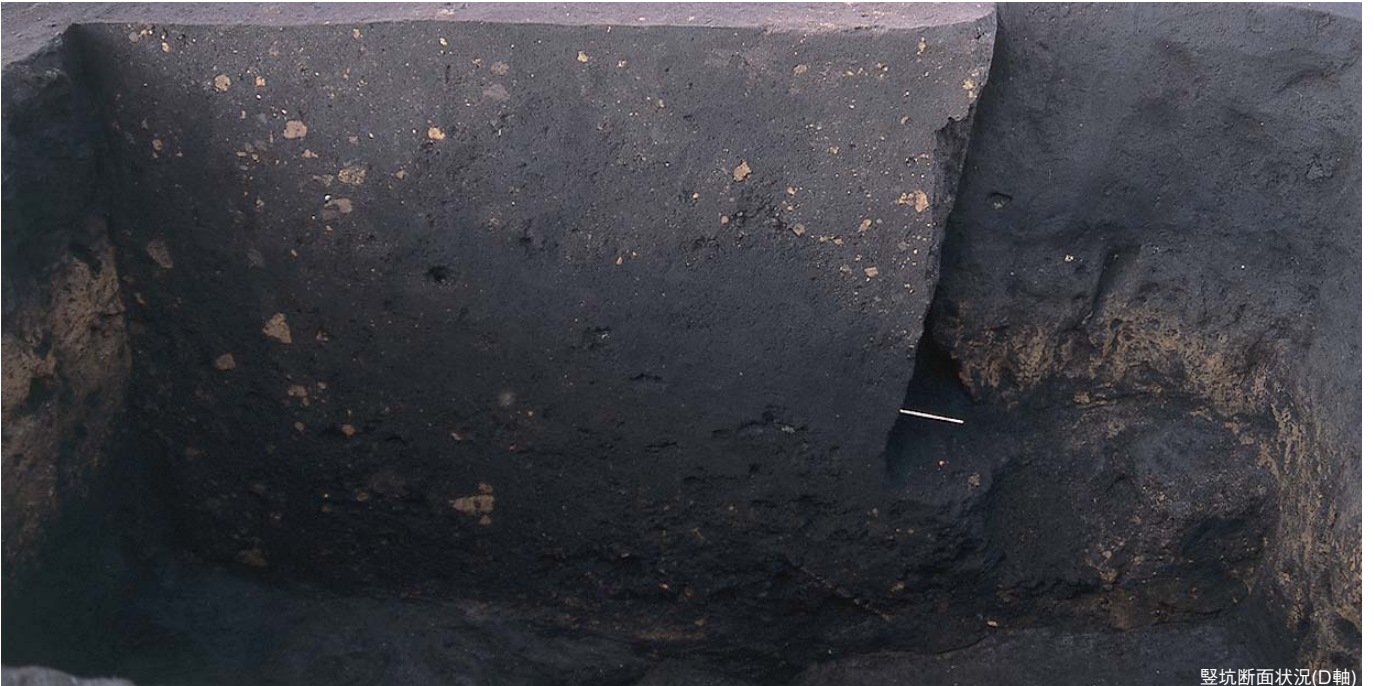
豎坑断面状況(D軸)
