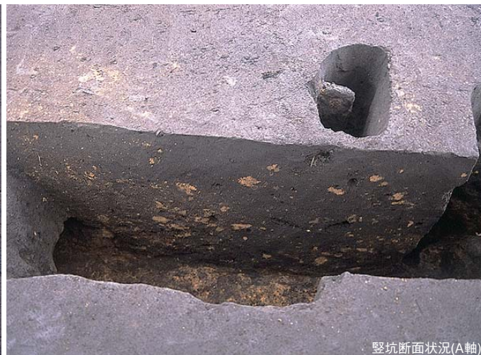
豎坑断面状況(A軸)
