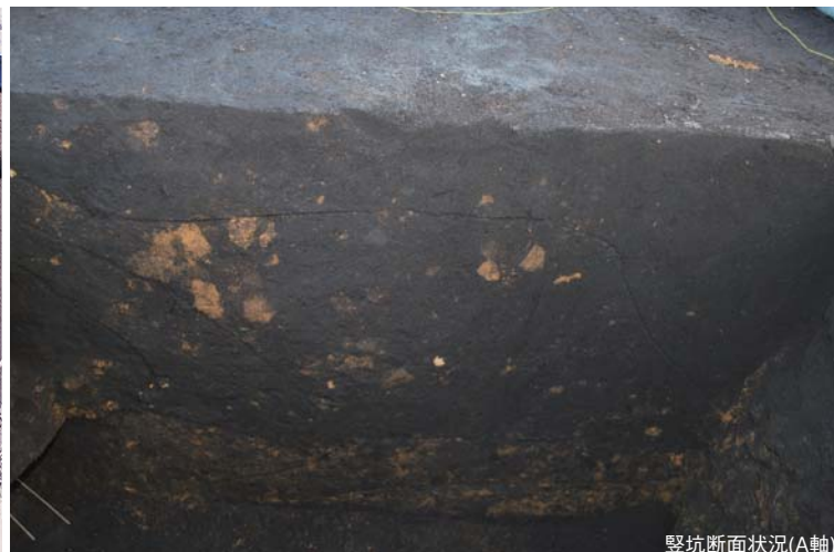
豎坑断面状況(A軸)
