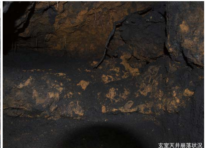
玄室天井崩落状況
