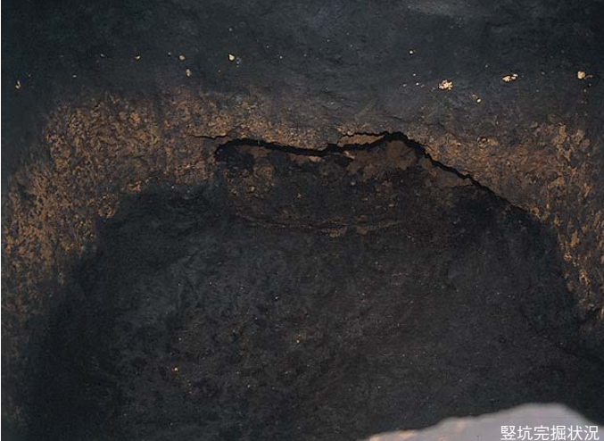
豎坑完掘状況
