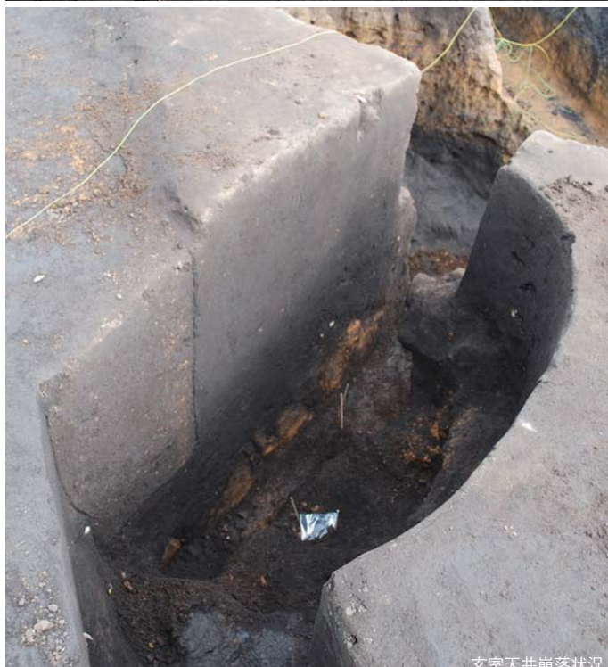
玄室天井崩落状況
