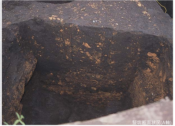
豎坑断面状況(A軸)
