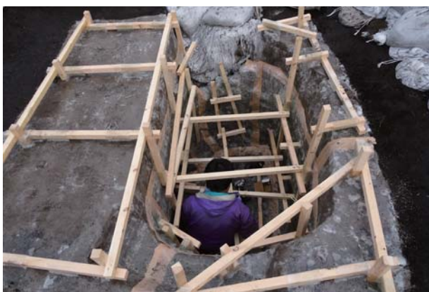
(2)ポリエステル樹脂積層・(3)角材補強
