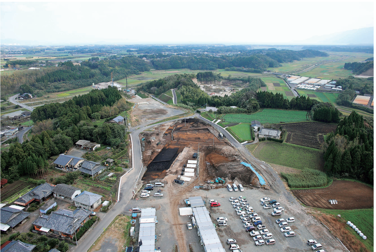
第2地点G地区と道路建設の進む永吉天神段遺跡
