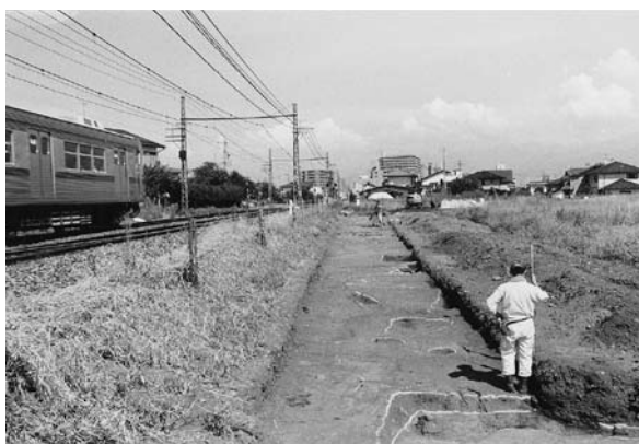
1号道路 遺構の測量
