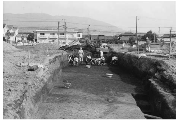
5号道路 遺構の検出
