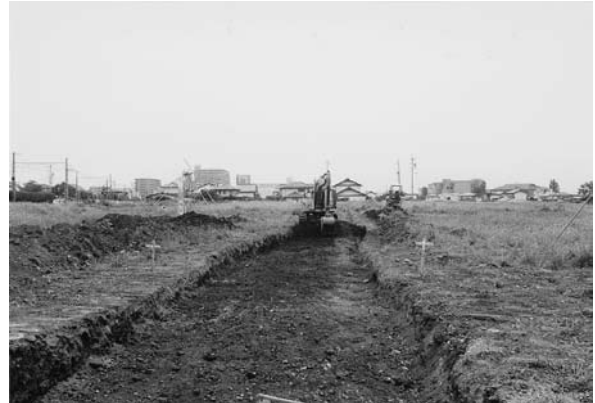
2号道路 表土の除去
