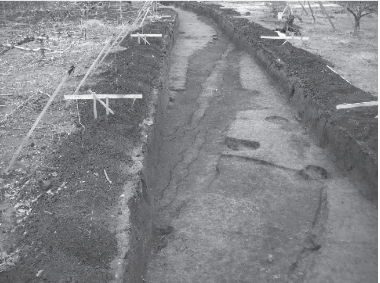
1 SF01硬化面確認状況（西から）
