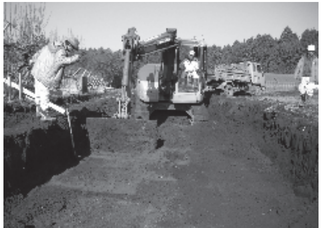
8 表土掘削状況2
