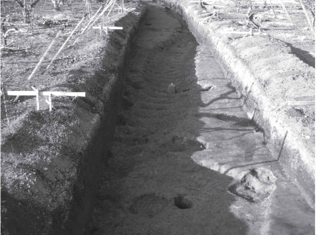
1 SF01掘り方完掘状況（西から）
