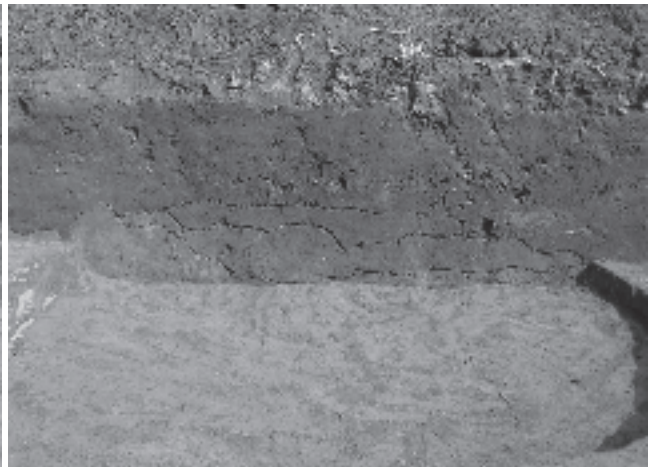
6 SK54セクション (南から)
