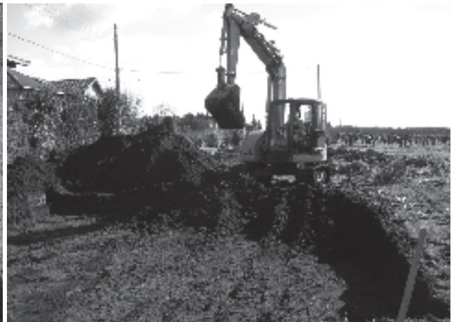
5 表土掘削状況（西から）
