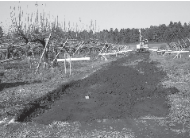
7 表土掘削状況1
