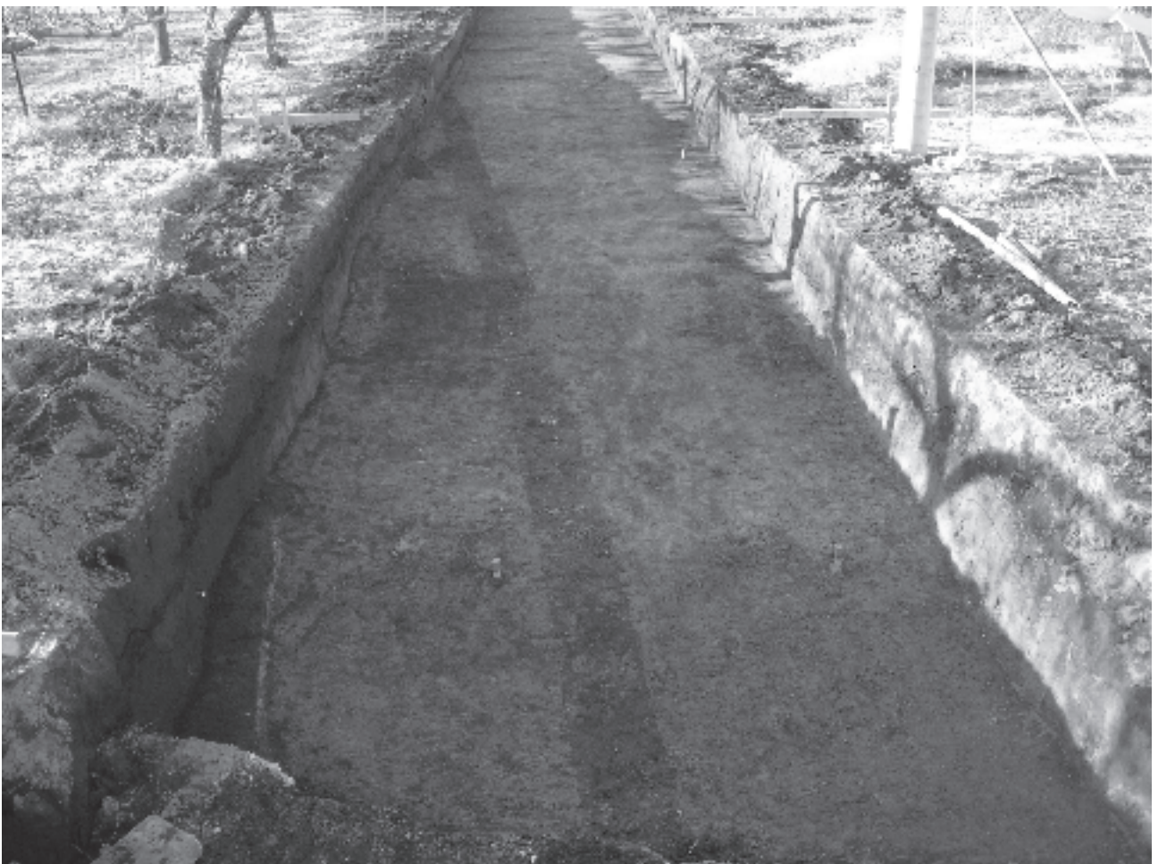
2 確認状況全景2 (東から)
