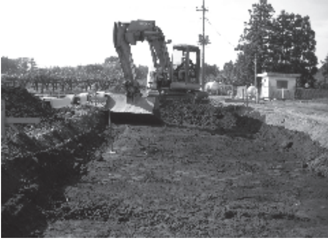
1 表土除去状況
