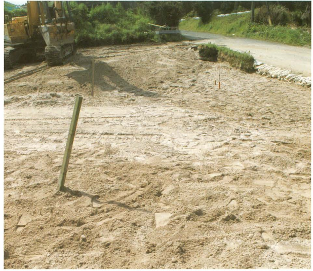
PI.181 埋め戻し作業状況写真⑭
