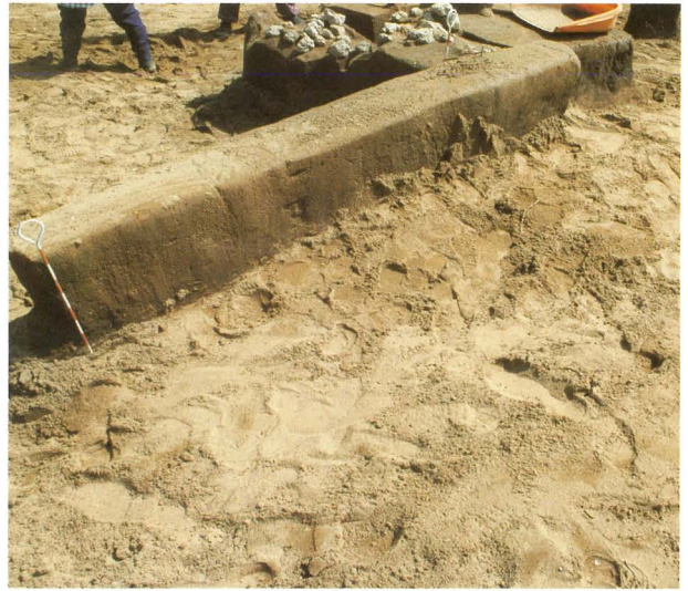
PI.175 埋め戻し作業状況写真⑧
