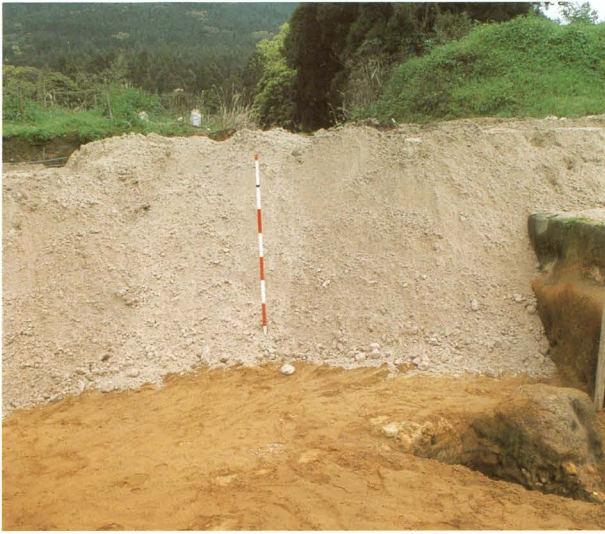
PI.180 埋め戻し作業状況写真⑬
