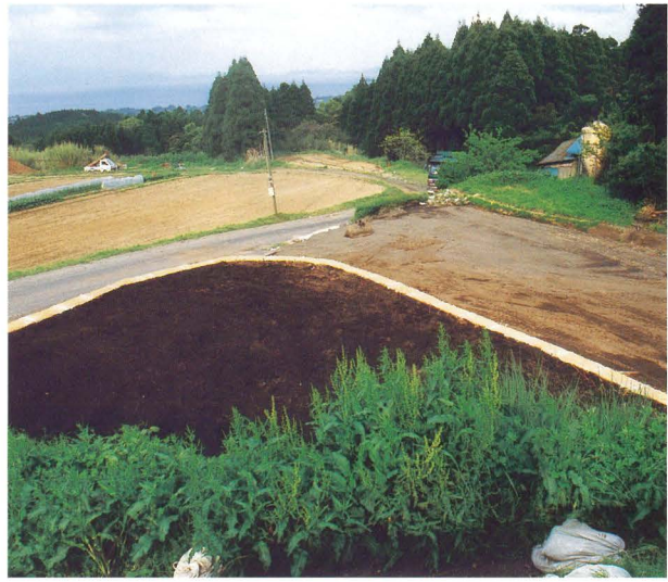
Pl.169 埋め戻し作業状況写真②
