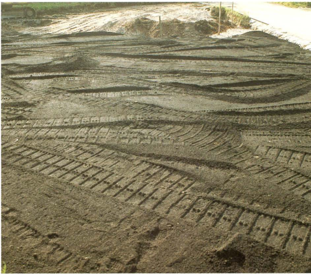
PI.182 埋め戻し作業状況写真⑮
