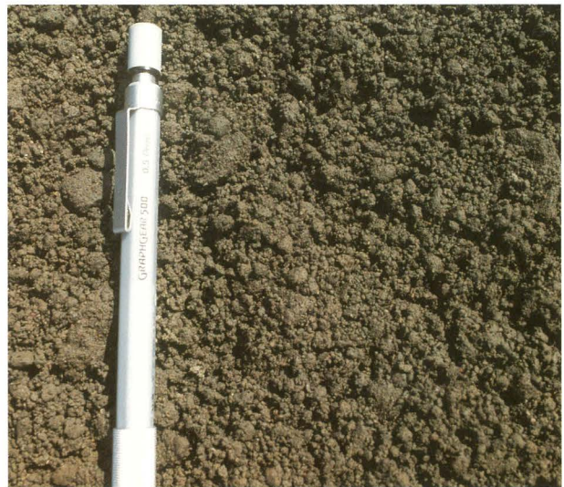
PI.185 埋め戻し作業状況写真⑱
