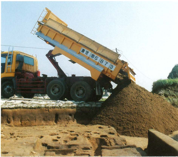
Pl.170 埋め戻し作業状況写真③
