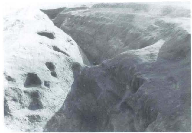
12号堀仕切（5F-32-17北側から）
