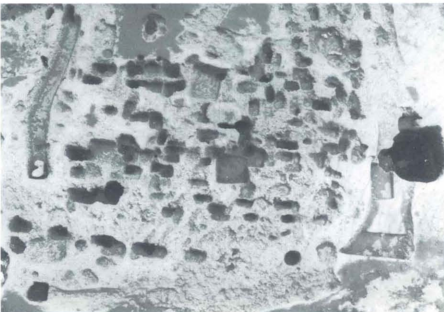
18～21号建物跡（上空から）
