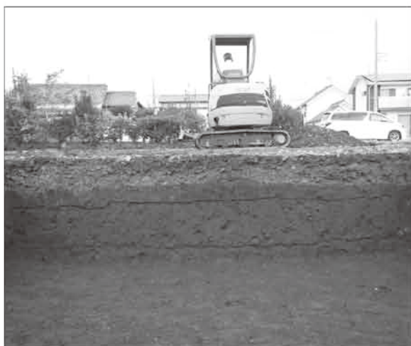
5. 断面 (3トレンチ)
