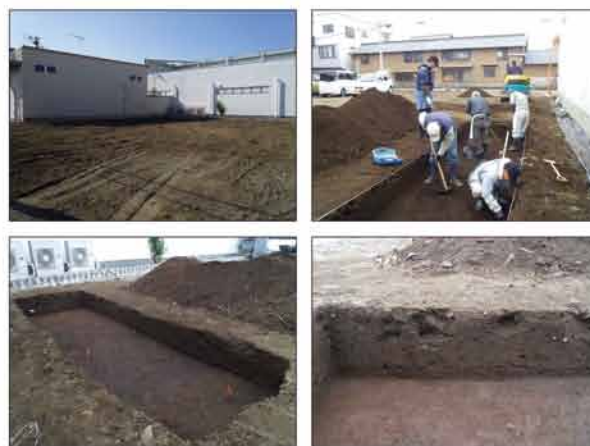
写真 調査状況
