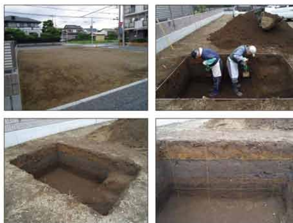
写真 調査状況
