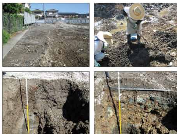
写真 調査状況
