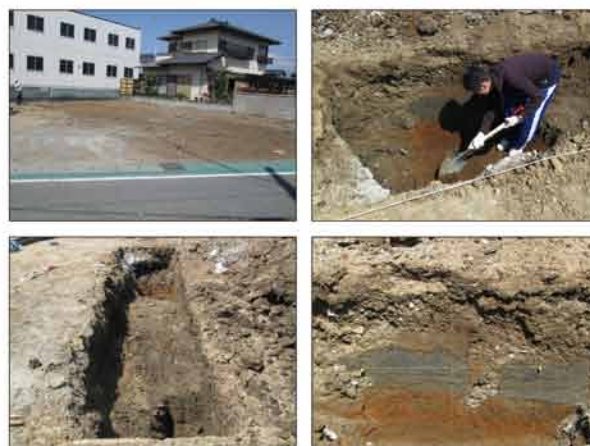
写真 調査状況
