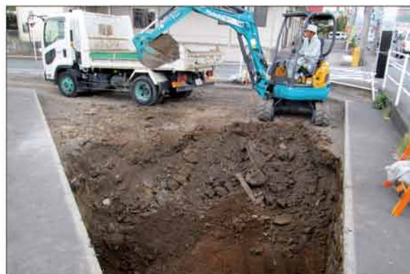
写真 調査状況
