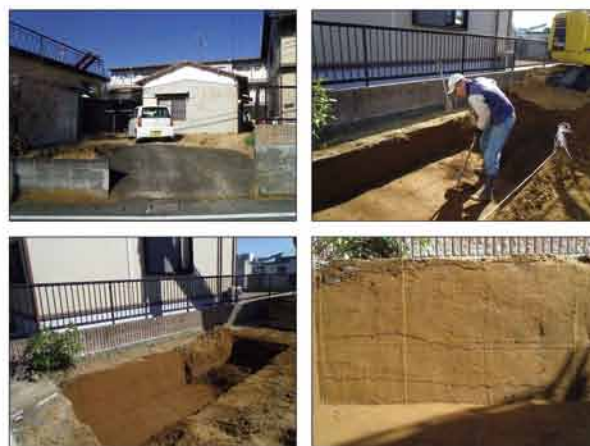
写真 調査状況
