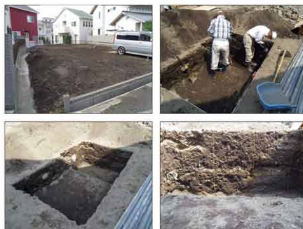
写真 調査状況
