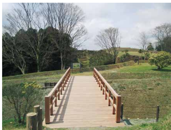
写真 再整備された二ノ丸西堀橋
