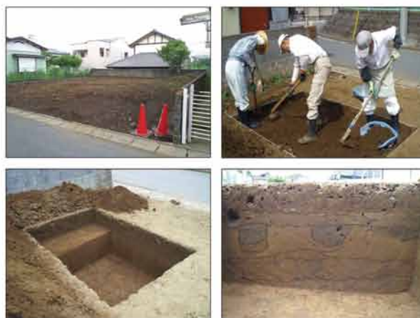
写真 調査状況
