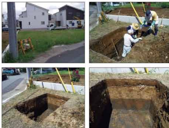
写真 調査状況
