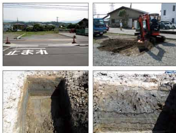
写真 調査状況
