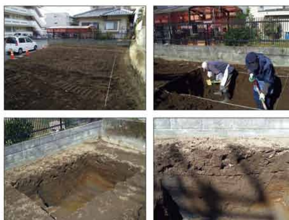
写真 調査状況
