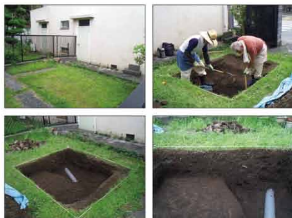
写真 調査状況
