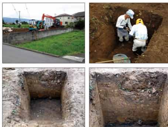
写真 調査状況
