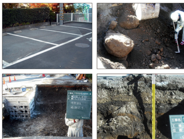
写真 調査状況
