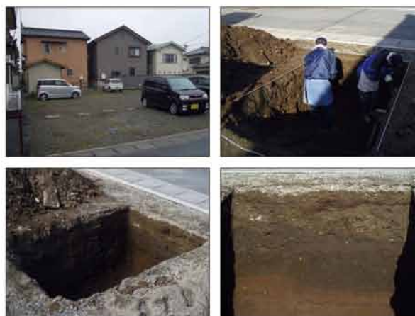
写真 調査状況
