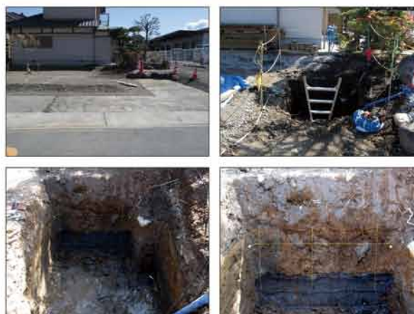
写真 調査状況
