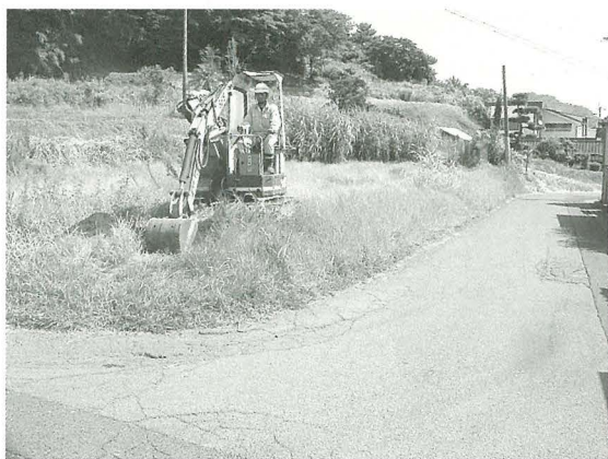
1. 試掘地点（4トレンチ付近）
