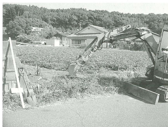
2. 試掘地点（2トレンチ付近）
