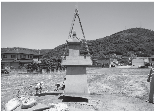
写真3-1 バックホウによる既存祠の撤去
