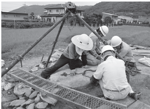
写真3-2 三又とチェーンブロックによる石室天井石撤去
