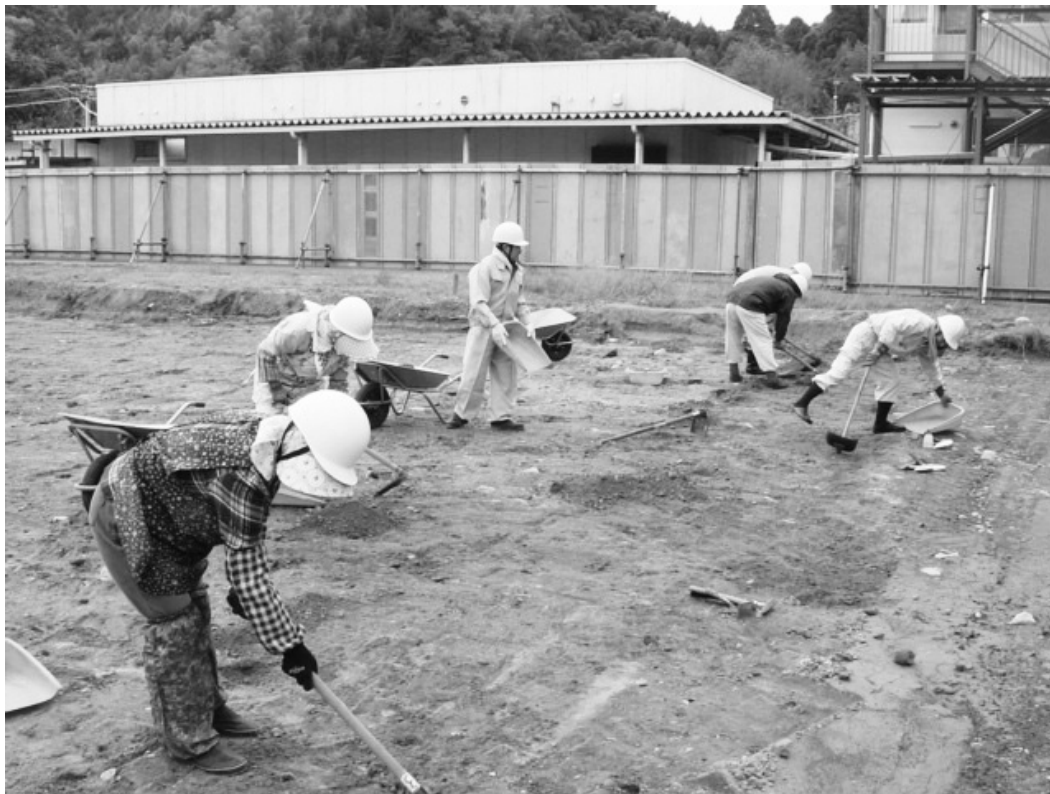
御仮屋地点 表土除去作業状況
