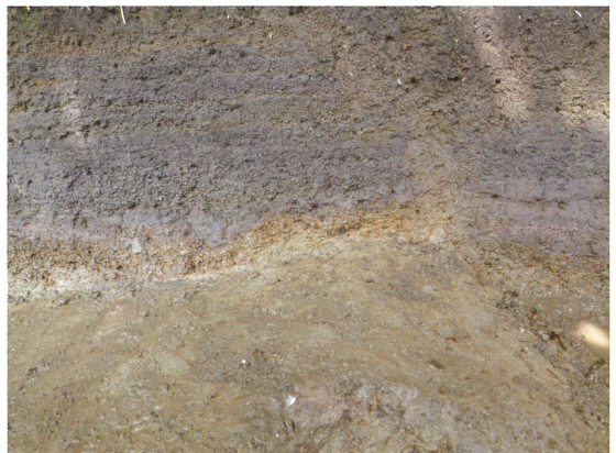
写真14 蛙埋没状況②(西壁)
