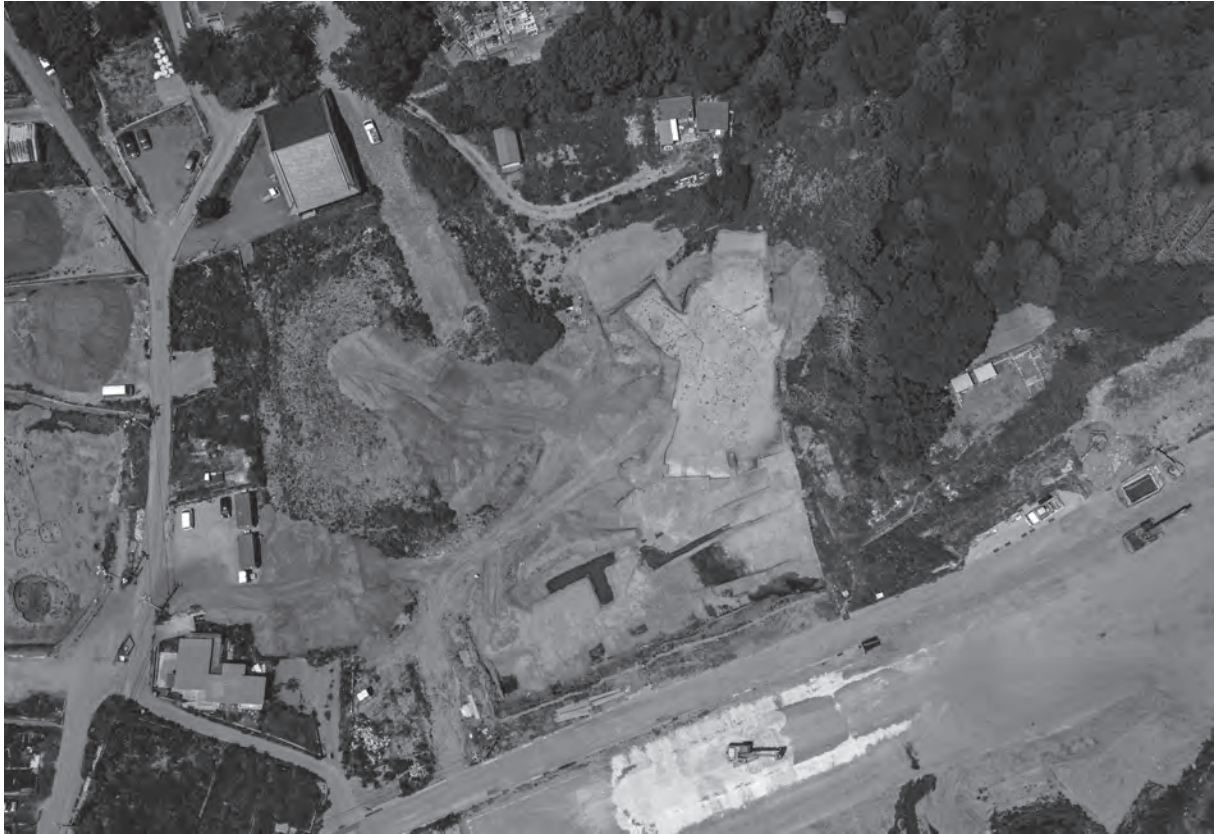
A区全景(直上→)
