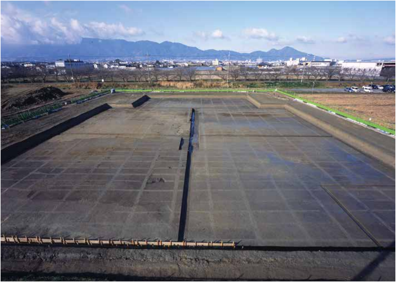
写真1 上層遺構検出状況 - 東から (右奥は二上山) -
