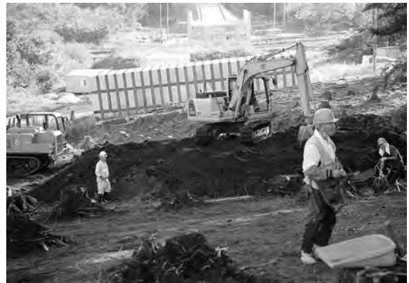
平成28年度重機稼働状況
