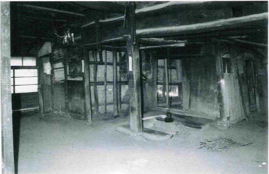
解体前土間（南より）
