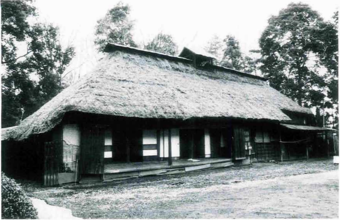
解体前島田家母屋（南より）
