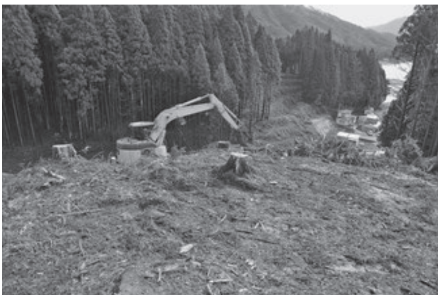
作業状況(6区) 西から
