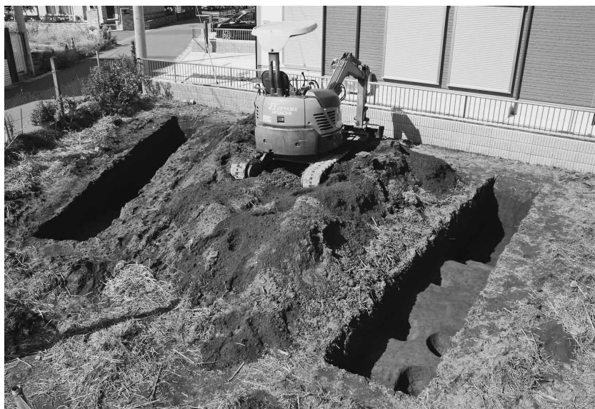
第11地点調査区全景
