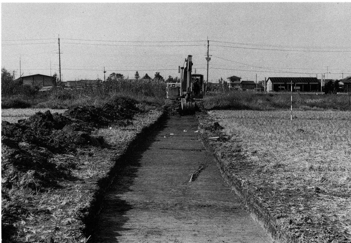
東側トレンチ掘削風景
