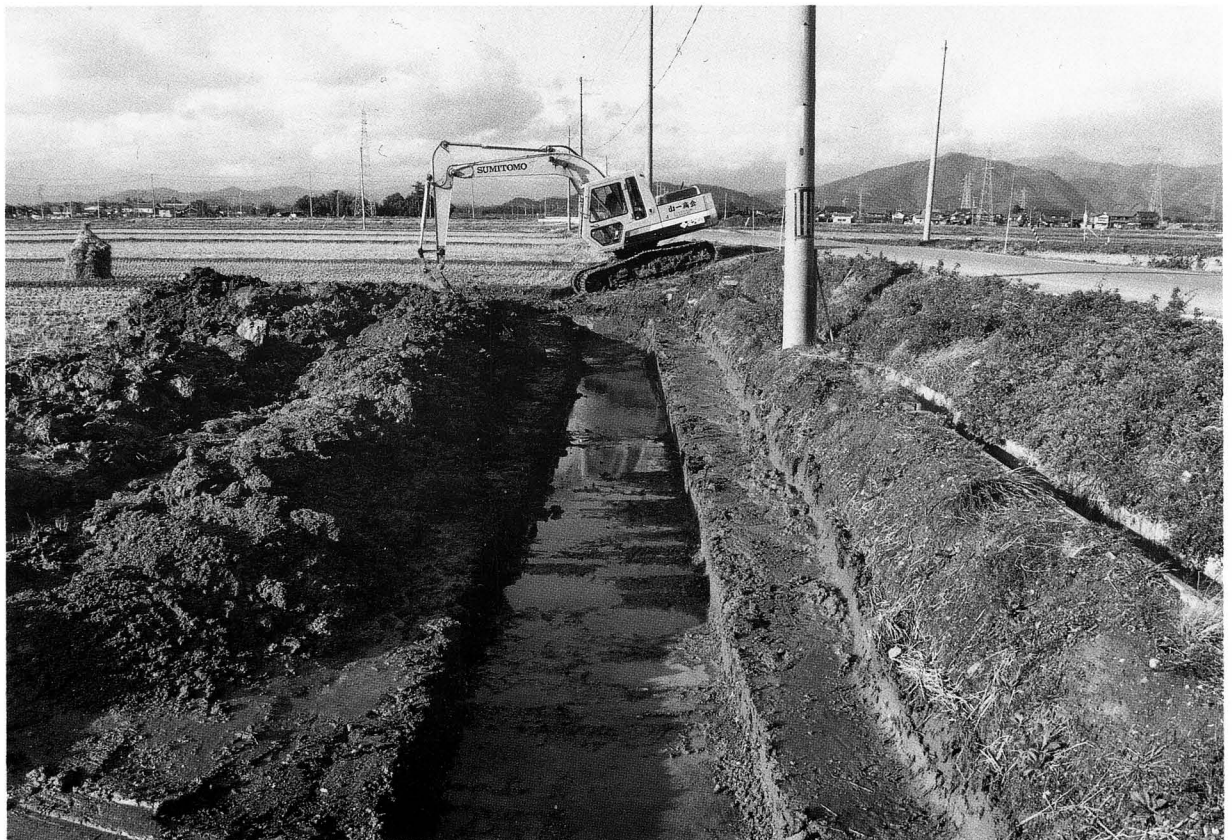
神照寺坊遺跡調査風景
