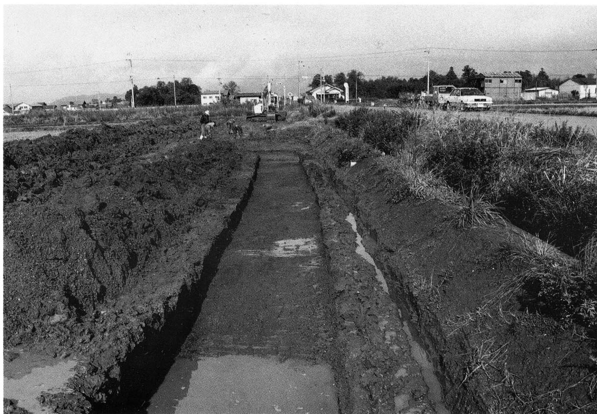
地蔵遺跡調査風景
