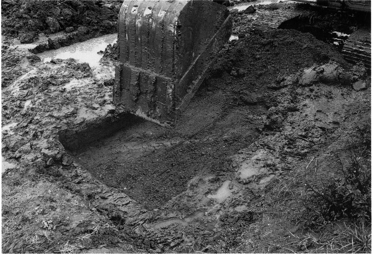
地藏遺跡掘削風景
