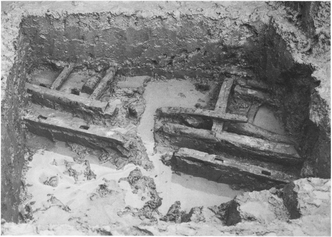
1. 木組み遺構（西より）
