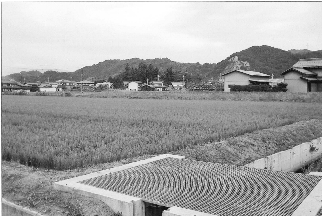
六反田遺跡 I 次 調査前状況 (南西から)
