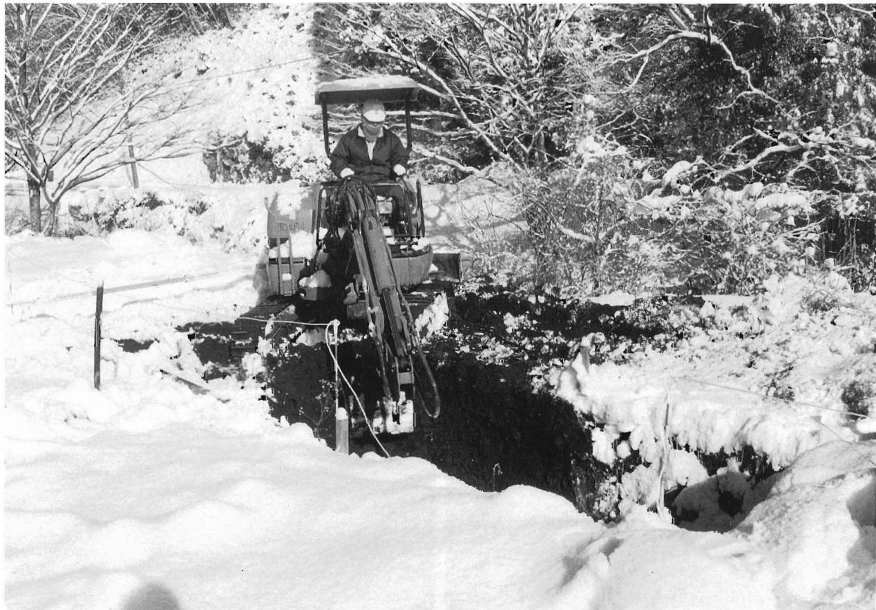
1. バックホーによる上位層の掘削作業
