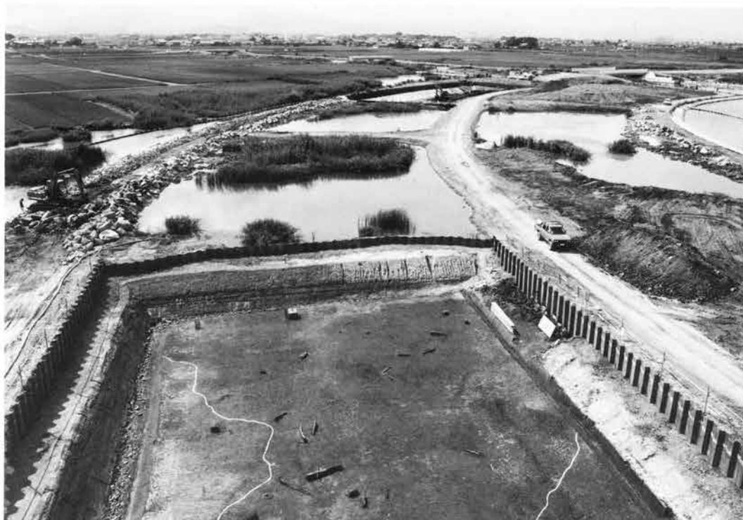
調査区周辺全景(手前が調査区)
