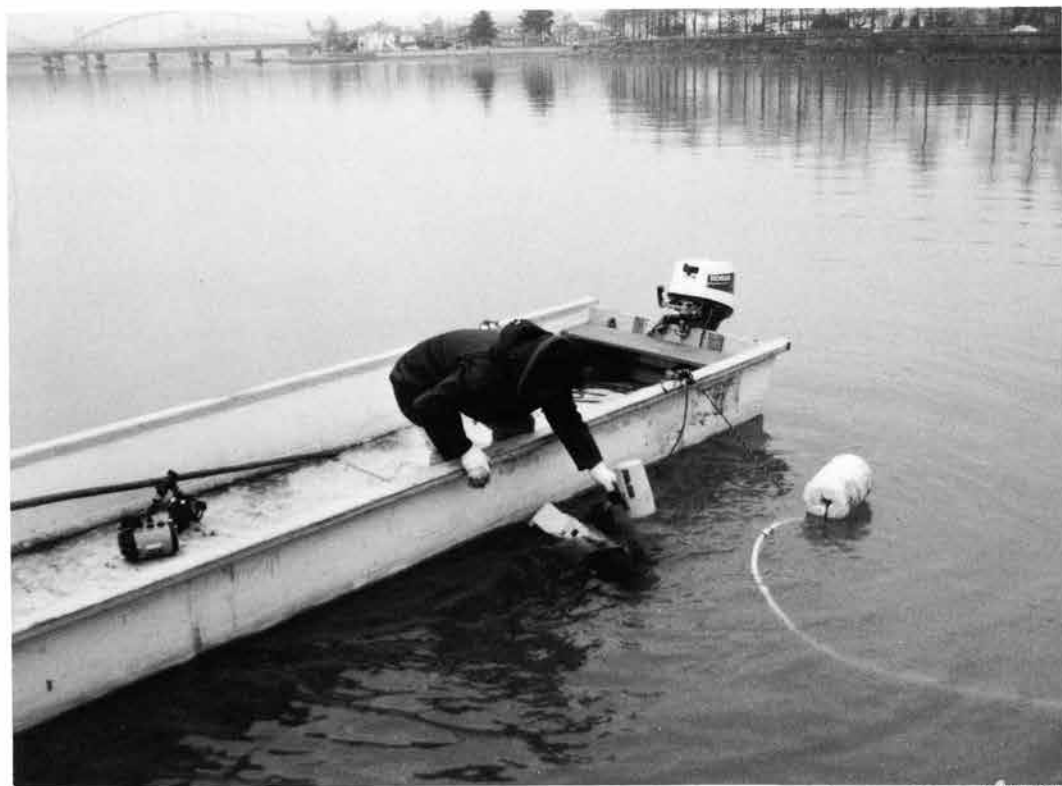
南湖航路浚渫 作業状況
