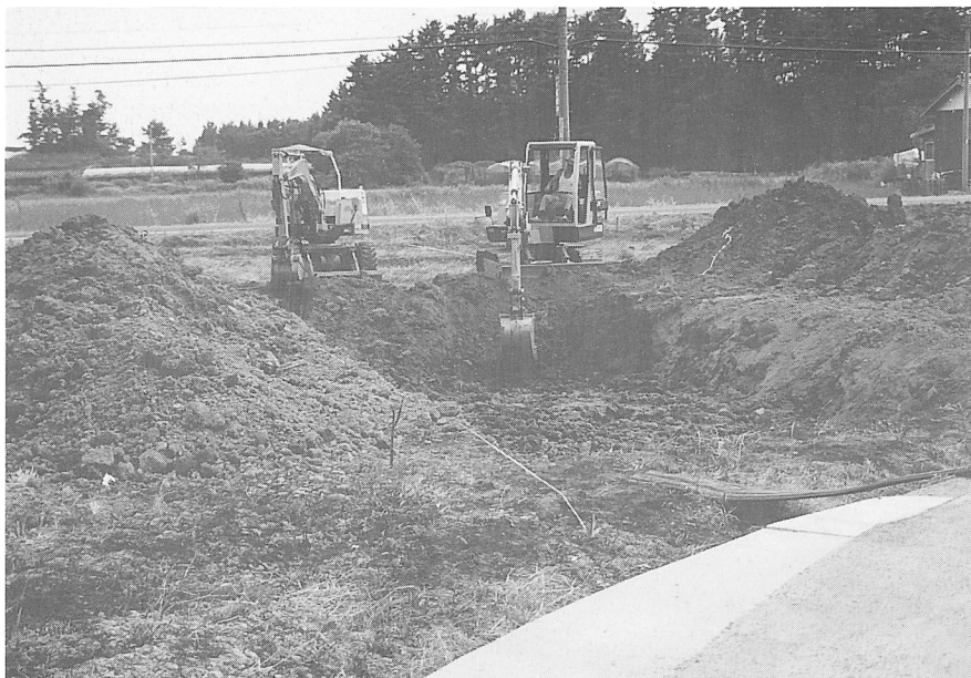
重機掘削風景
