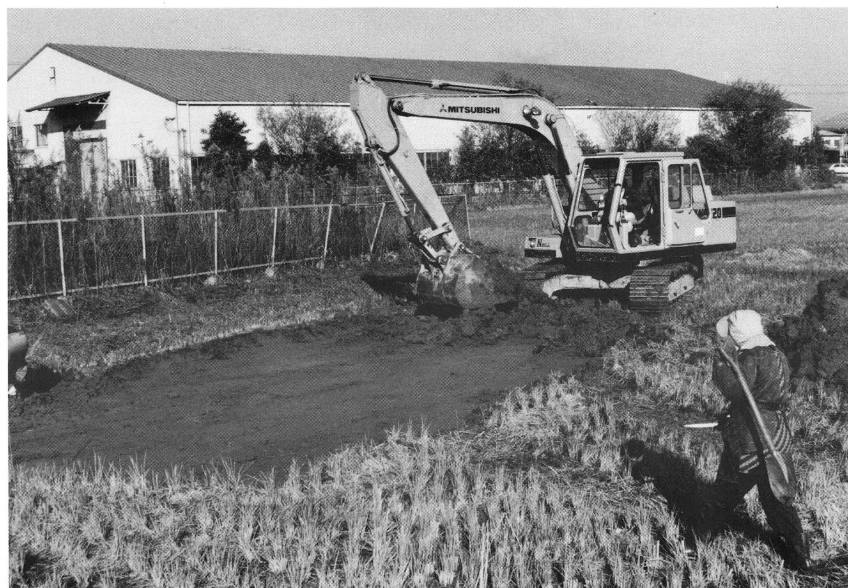
2. 表土除去作業
