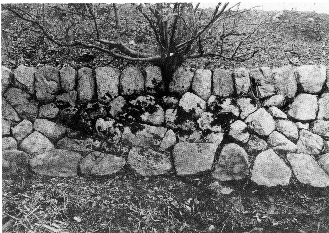
石積みの状況
