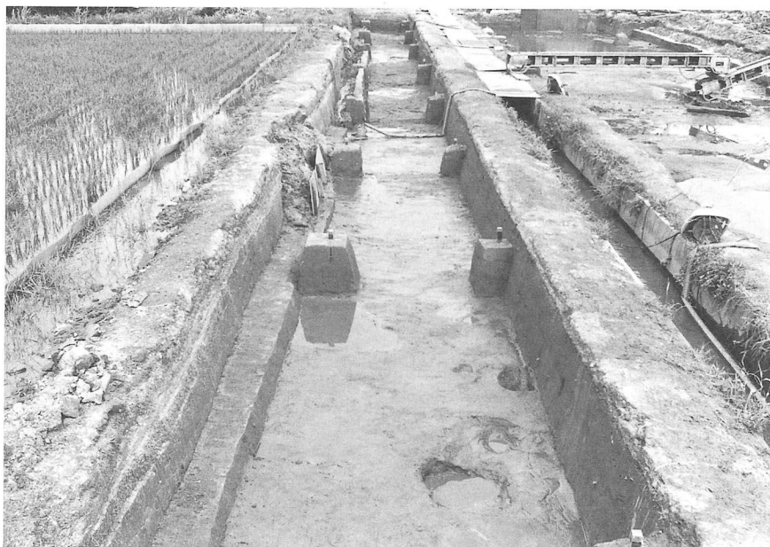
完掘状況 (北側調査区西より)
