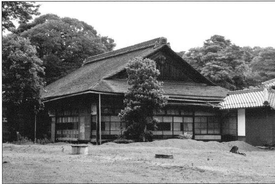
解体修理前の御書院外観（南西側）
