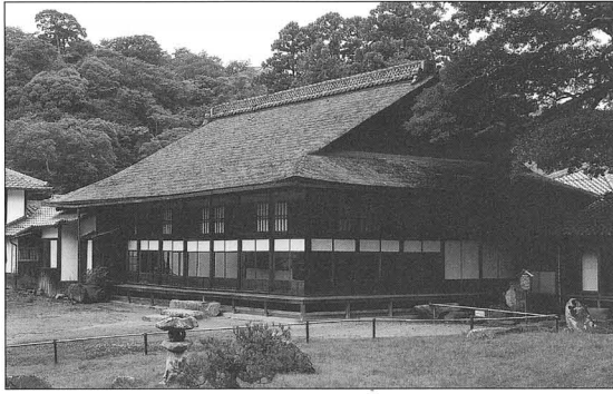
解体修理前の御書院外観（北東側）
