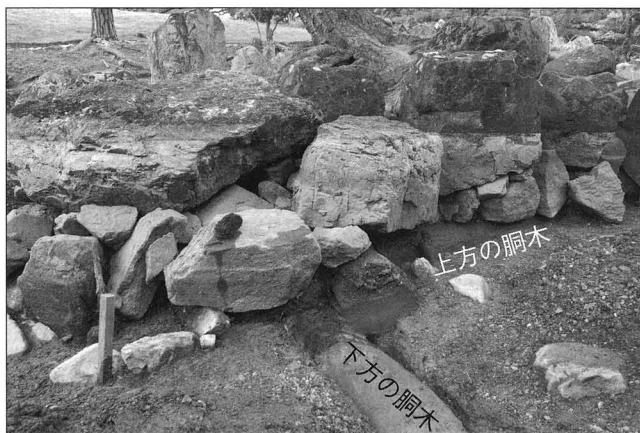
春風埜東側の護岸（詳細） 下方の胴木の上に粘土層があり、その粘土 層の上方に胴木が設置されている。江戸時 代に護岸の改修がなされて、胴木の再設置 が行われたようである。
