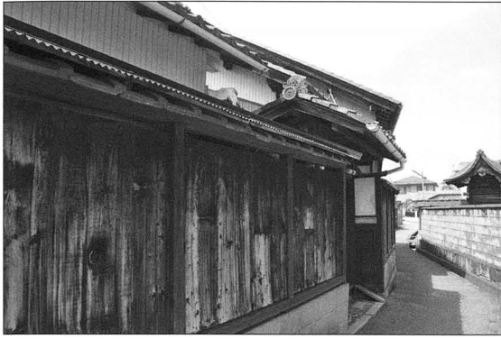
瀧谷家住宅外観
