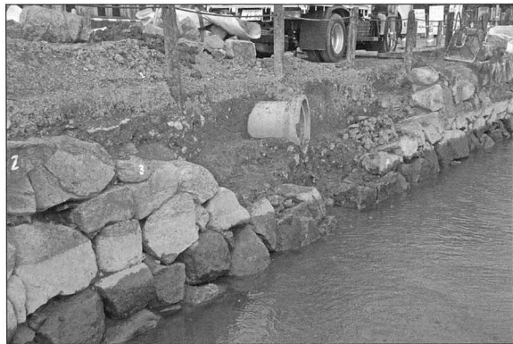
石垣の解体工事
