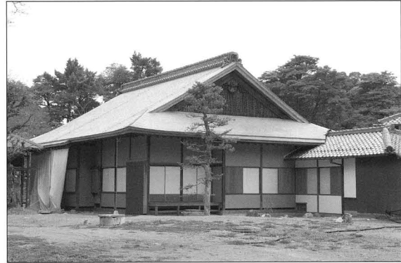
解体修理後の御書院外観（南西側）
