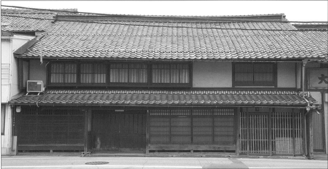
井戸家住宅外観
