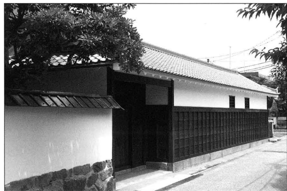
旧池田屋敷長屋門外観（修理後）
