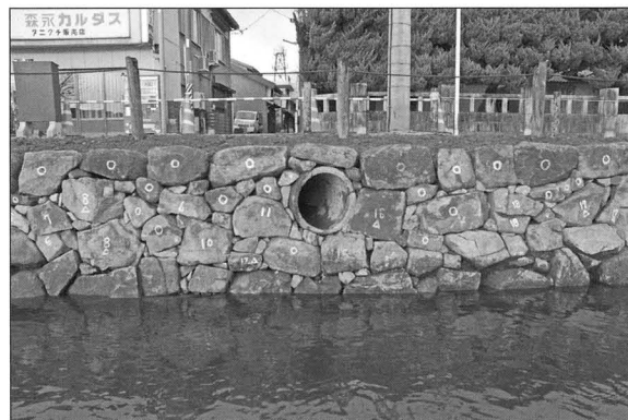
修理完了状況
