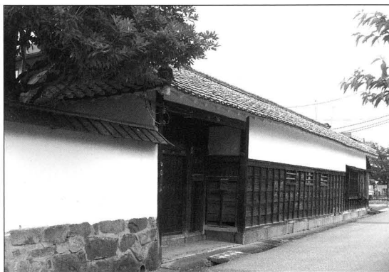
旧池田屋敷長屋門外観（修理前）
