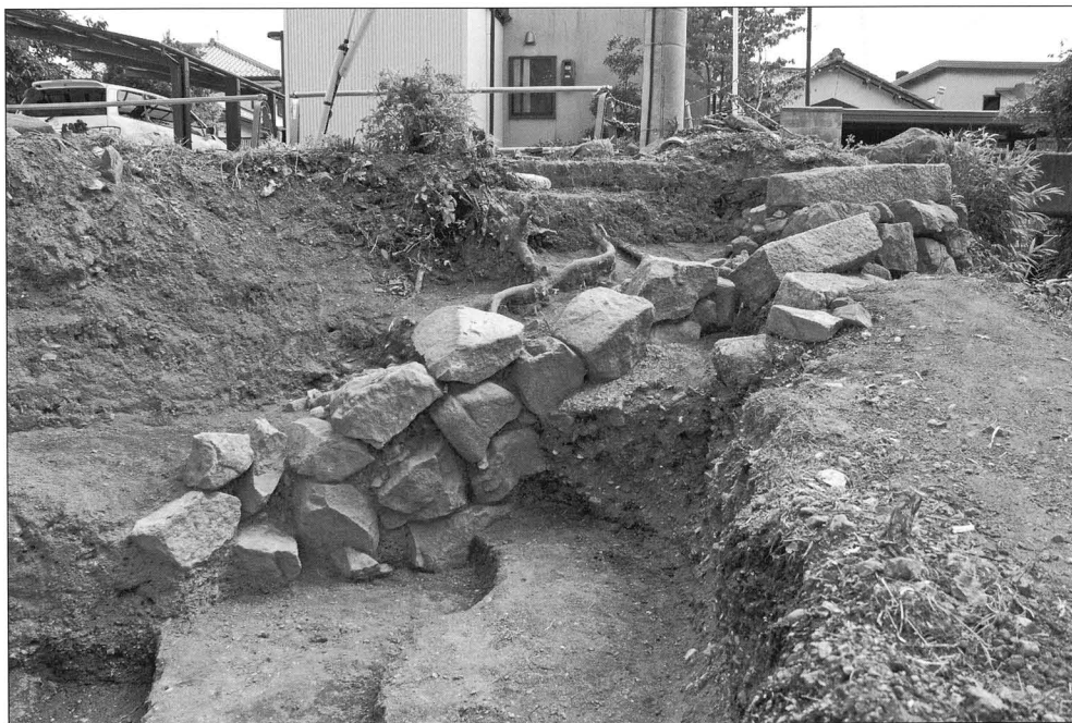
橋付近のみ検出した石垣（前頁絵図の矢印②）
