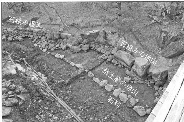
鳳翔台南側の護岸 鳳翔台南側の護岸は、石列まで粘土層の地山が明瞭に検出できた。この位置では、石列が石積み護岸の下に潜り込むように検出されており、石積み護岸や手前の石組み護岸が江戸時代に改修されていることが判明した。
