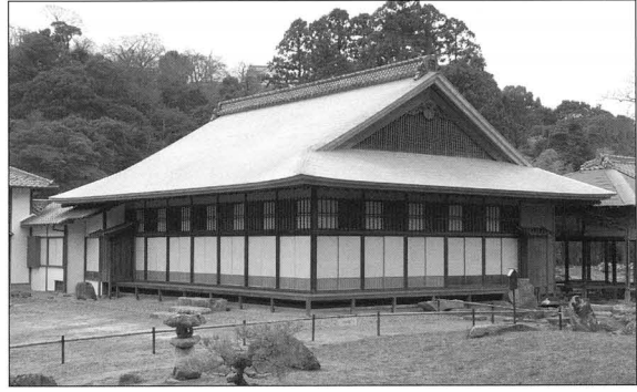
解体修理後の御書院外観（北東側）
