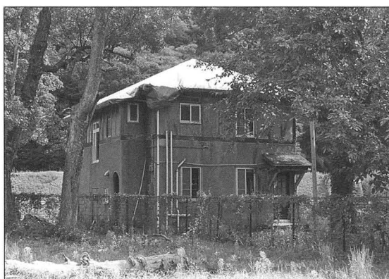
保存修理前の北館
