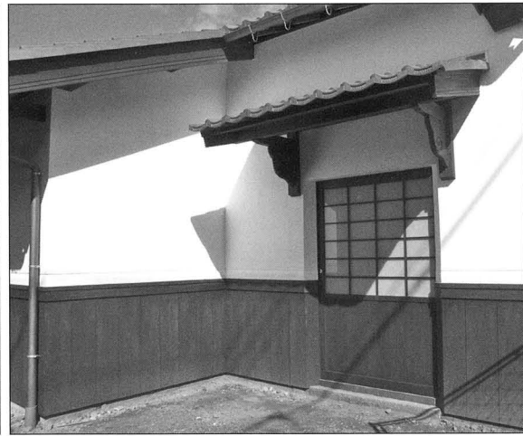
吉居家住宅の建物南西側の入口の復元
