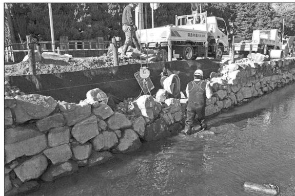
石垣の積み直し工事
