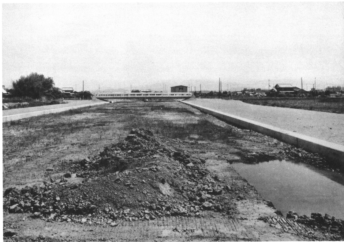
III区調査前全景（下流より）
