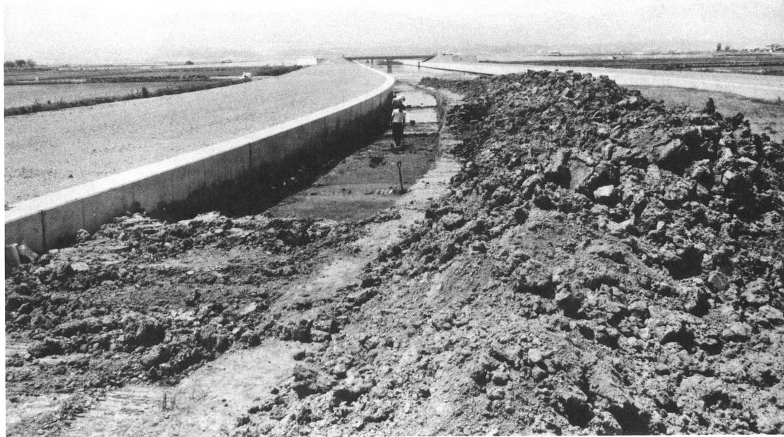
I区調査風景（上流より）
