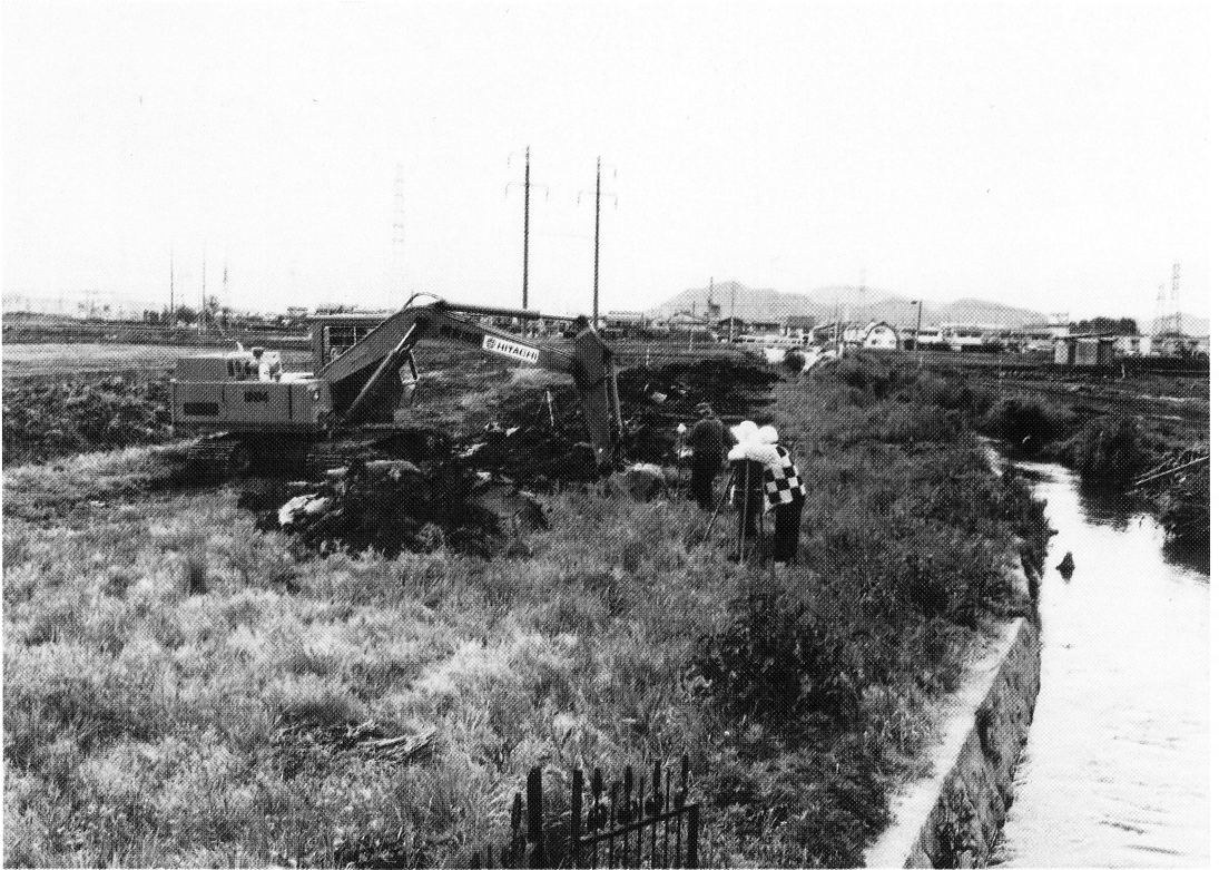
調査風景（試掘トレンチ）
