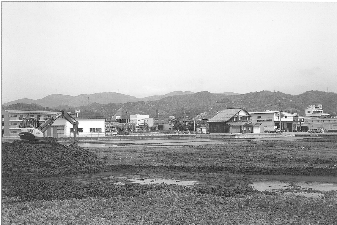
1 調査状況（北から）
