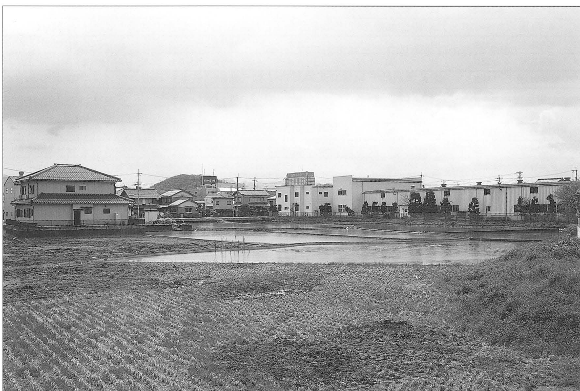
2 調査前風景（北から）
