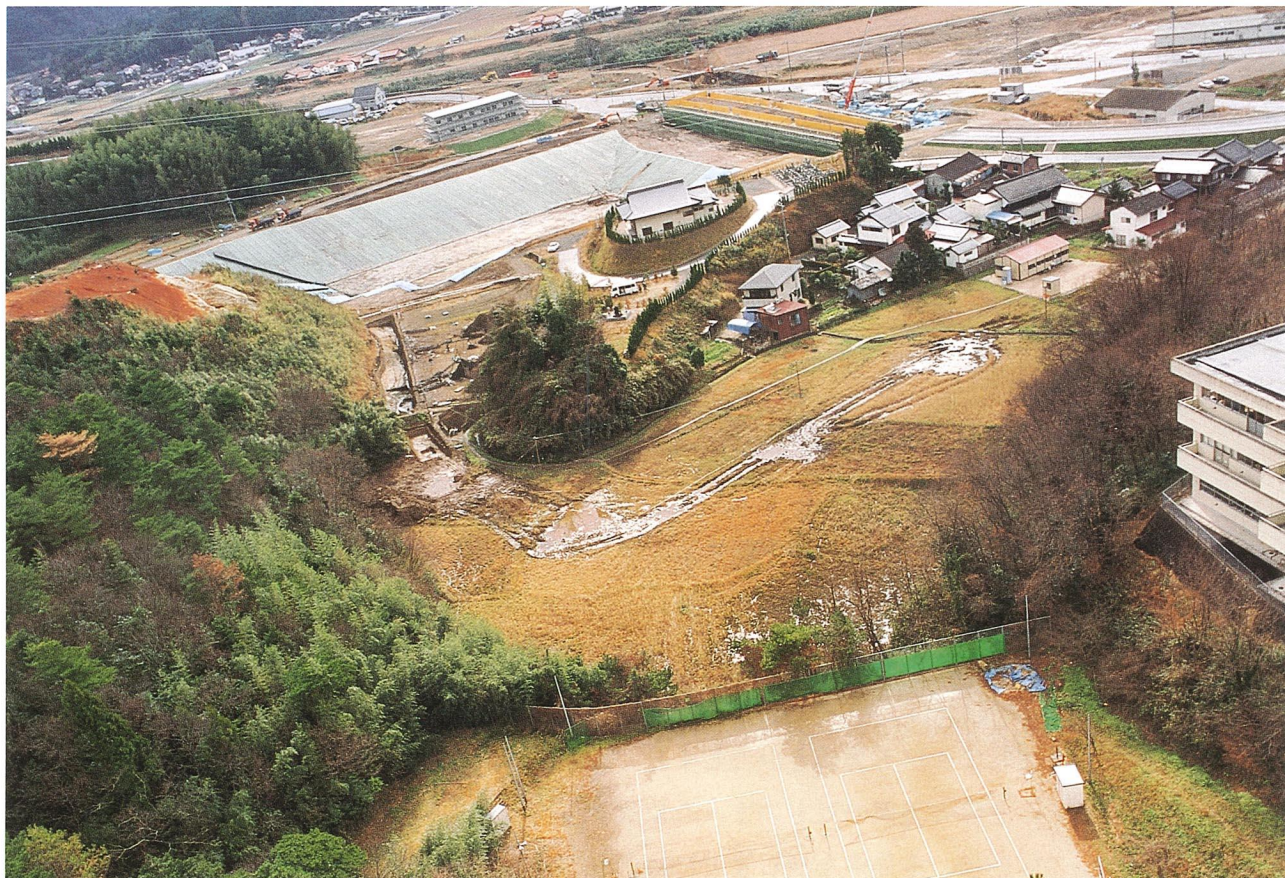
c区 空撮 北より
