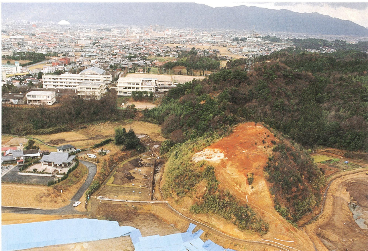
c区 空撮 南より
