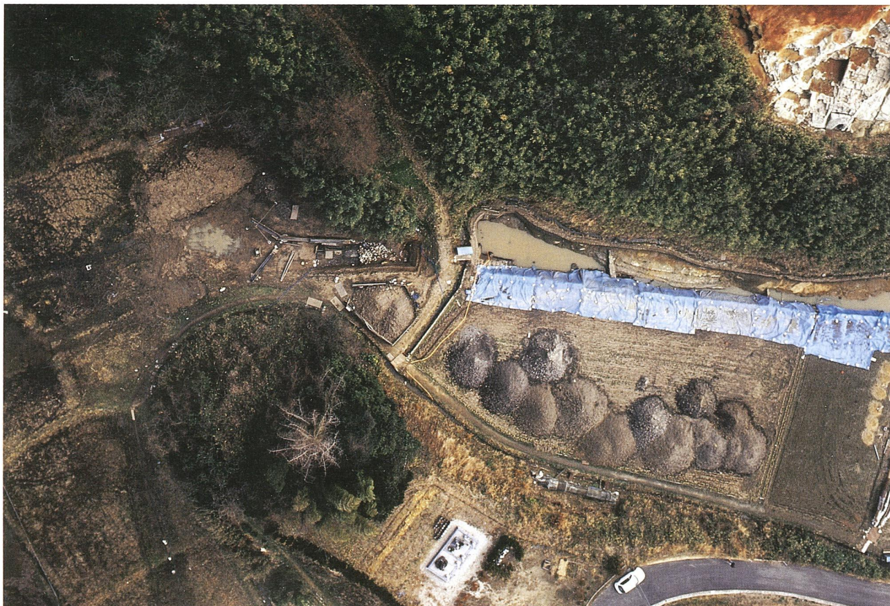
b区 空撮 西より
