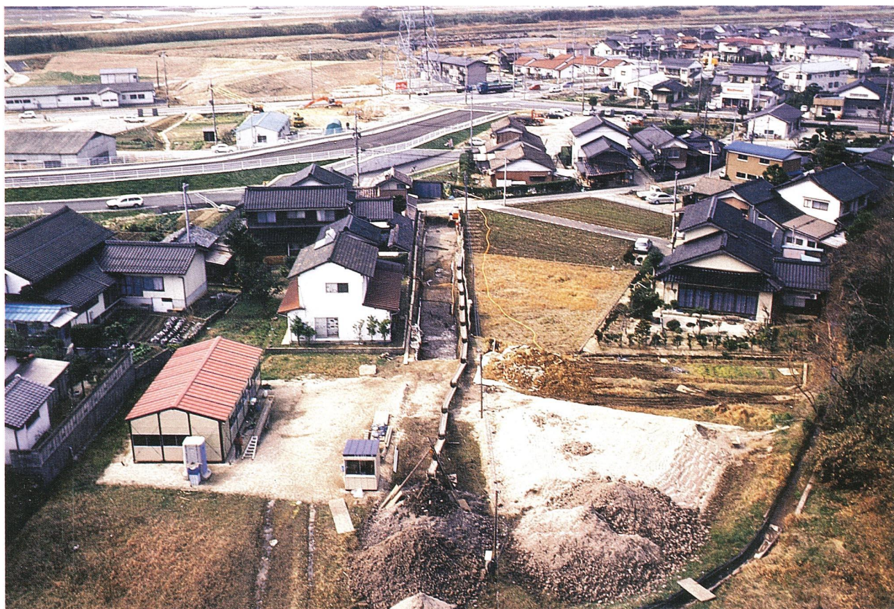
a区 空撮 東より
