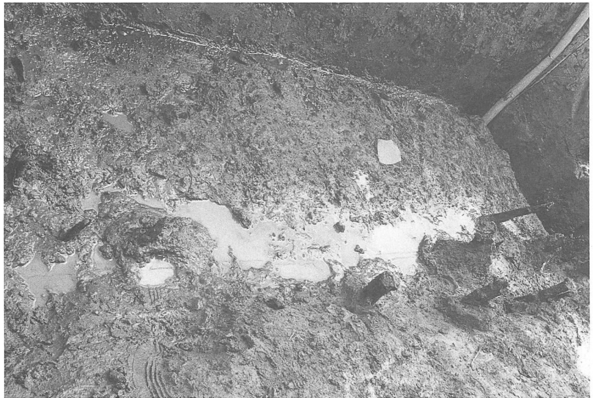
c区 杭列3・木クズ集中1 検出状況
