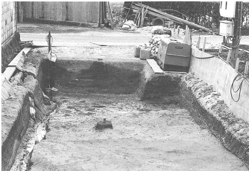
a 区 西側旧河道への落ち際
